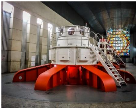
Гидрогенератор для выработки электроэнергии на ГЭС
