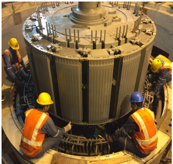
Установка гидрогенератора
